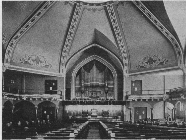
INTERIOR FIRST M. E.
